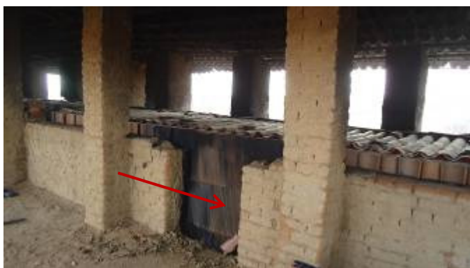
Figura 6 - Abertura indicada pela seta para carregamento do forno, aberta após a queima.
